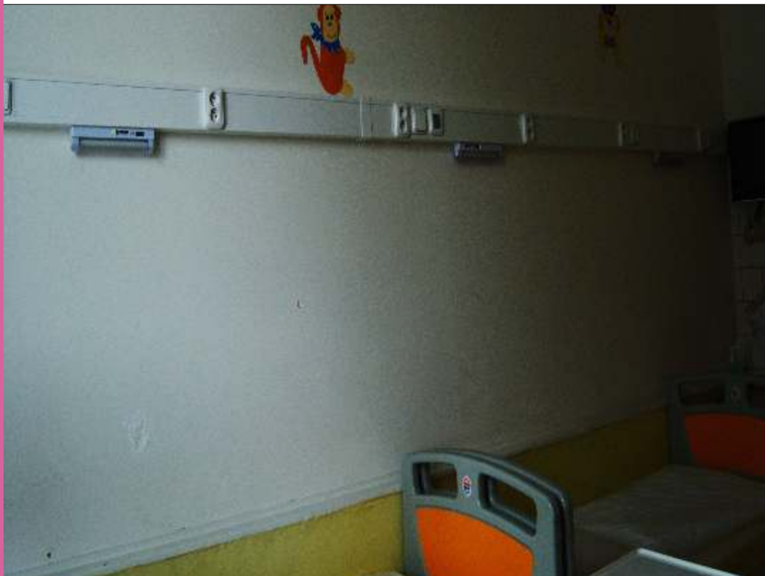
Fotografie: čelní stěna - před výmalbou
