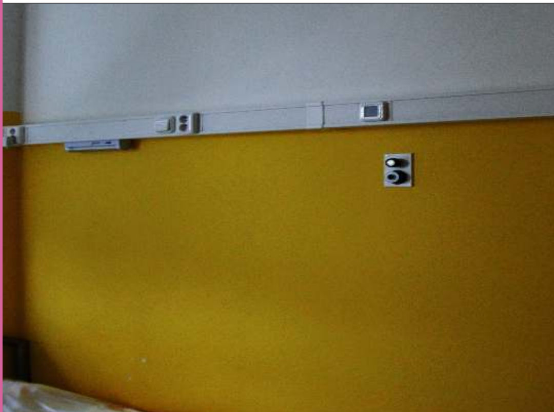
Fotografie: čelní stěna - před výmalbou
