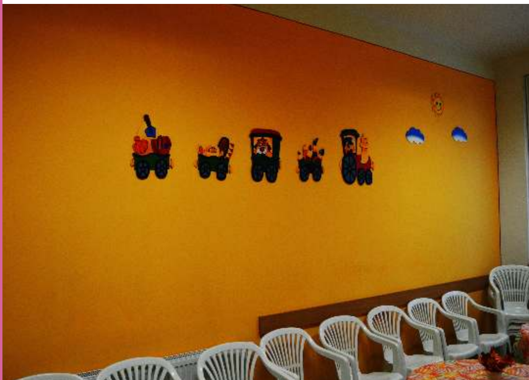
Fotografie: čelní stěna - před výmalbou
