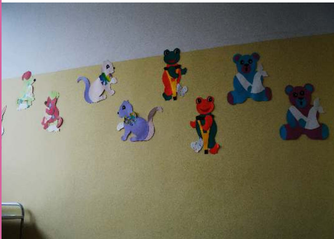
Fotografie: čelní stěna - před výmalbou
