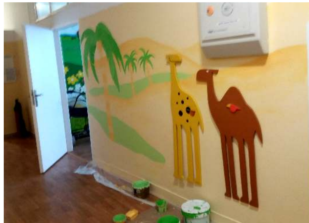
Fotografie: čelní stěna - po výmalbě
