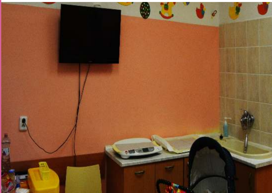
Fotografie: čelní stěna - před výmalbou
