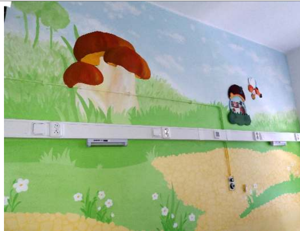
Fotografie: čelní stěna - po výmalbě
