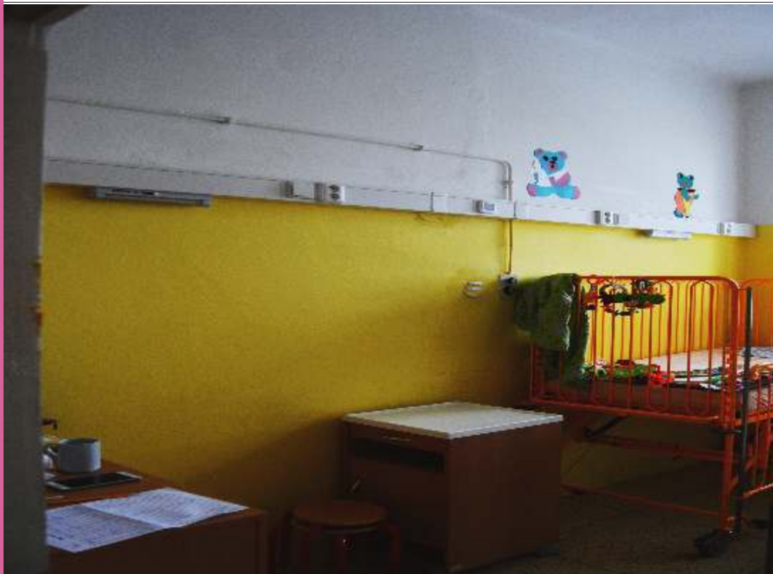
Fotografie: čelní stěna - před výmalbou
