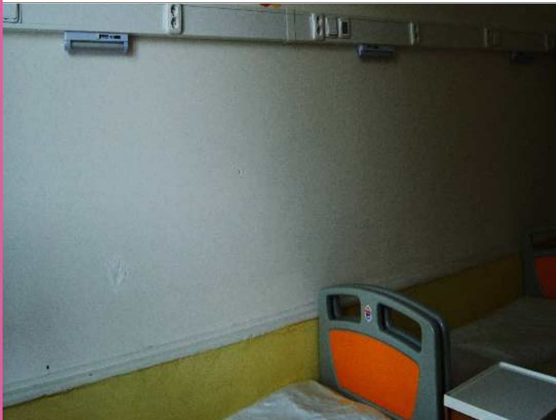
Fotografie: čelní stěna - před výmalbou
