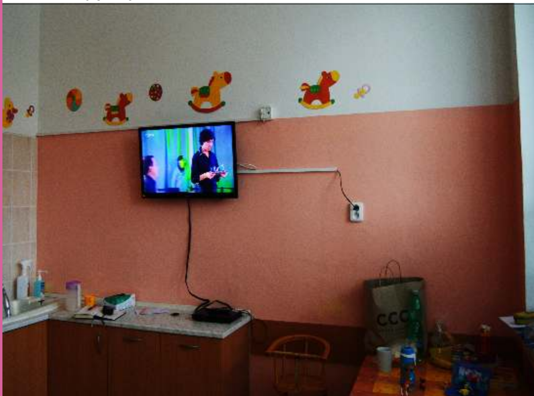
Fotografie: čelní stěna - před výmalbou
